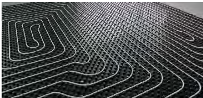
Obr. č. 9: Vedení potrubí podlahového vytápění
