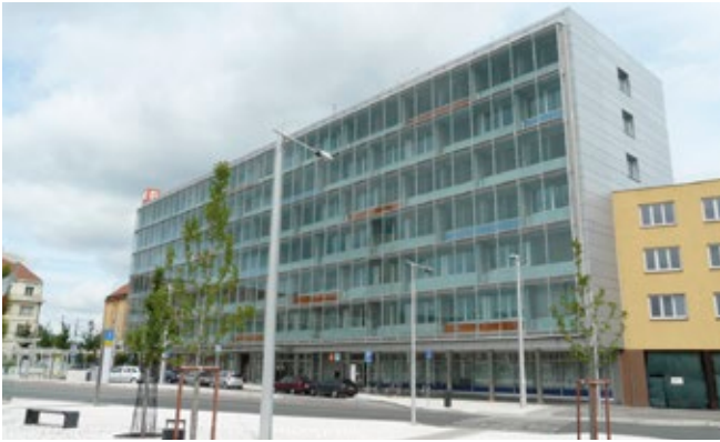
Head office ČEZ Hradec Králové CZ, 2006 - CoolPLATE
