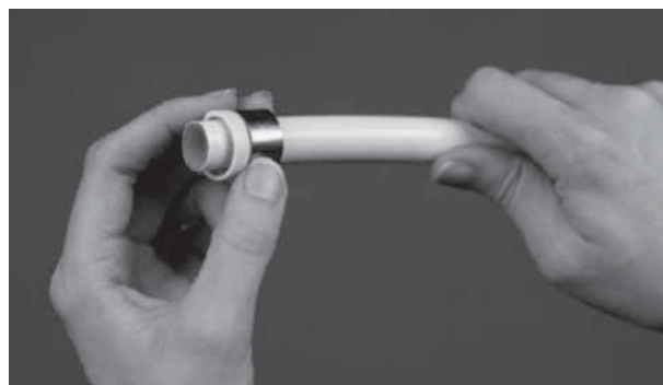
2. Nasuňte tlakový kroužek A-PRESS na trubku.
